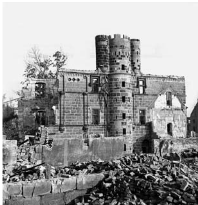
Der Bombenangriff vom 2. Januar 1945 zerstörte das Tucherschloss bis auf drei Außenmauern. Foto: 1945 Bildnachweis: Stadtarchiv Nürnberg (StadtAN A39/III Nr. Fi-H-59)
